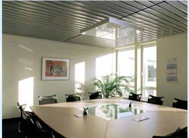
Statisches Kühldeckensystem SKS-5/3
