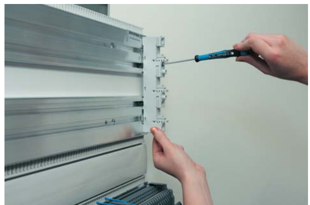
Schritt 4: Komponente ggf. ausrichten und einfach befestigen.
