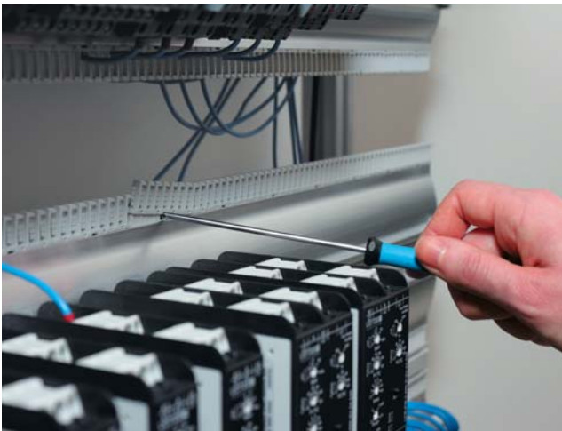
Schritt 1: Lösen der Kämme mit einem Schraubenzieher
