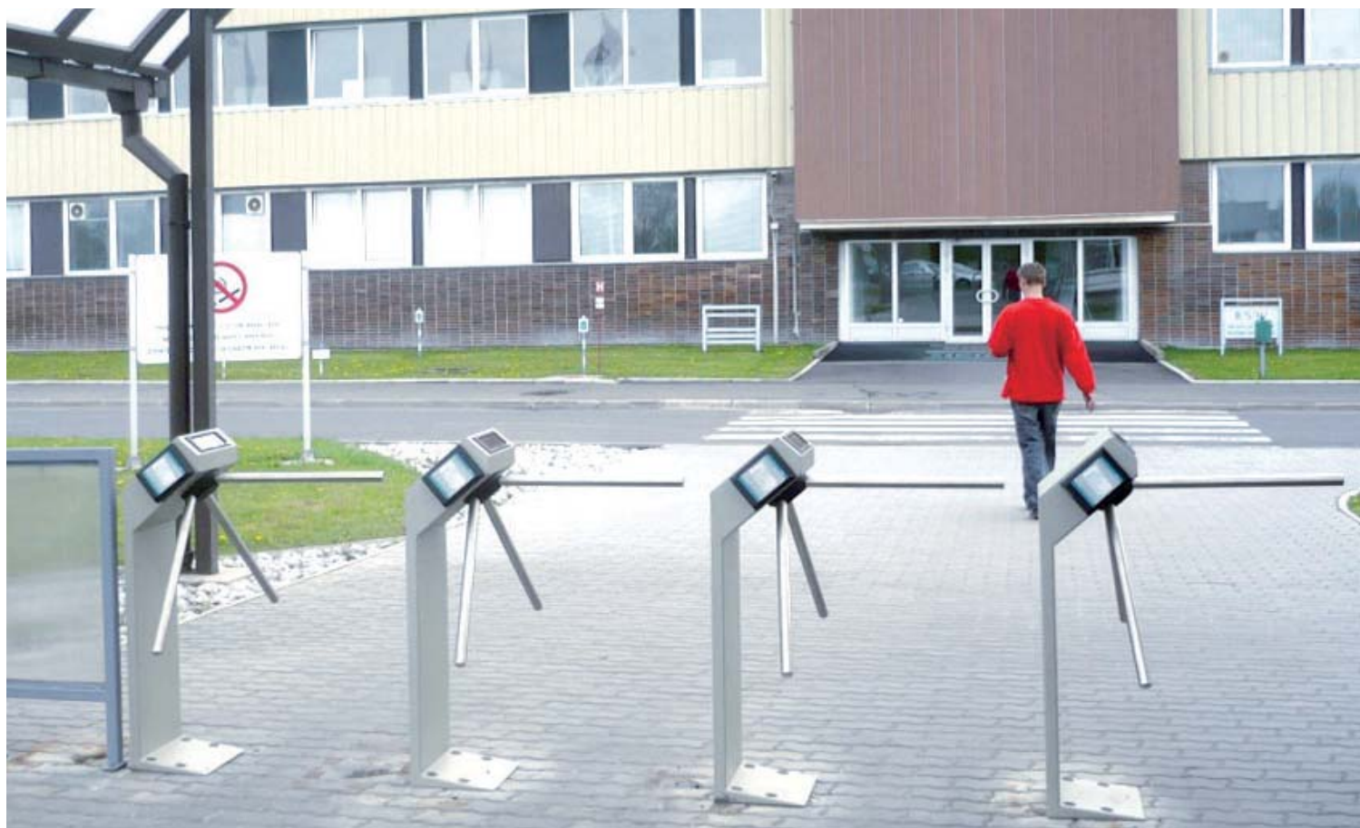
TTR-04CW tripod turnstiles, BSH Bosch und Siemens Hausgerdte GmbH office, Slovakia
