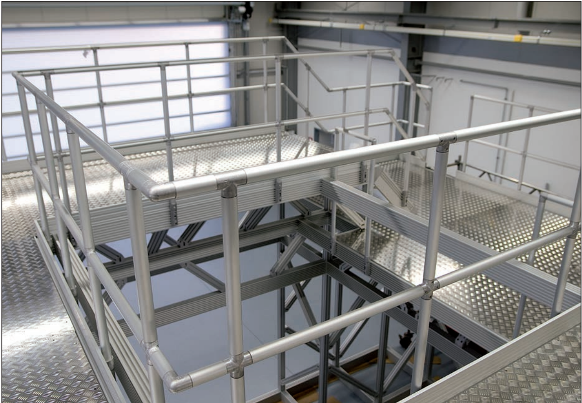
Umlaufendes Podest in einer Montagehalle mit mehrfachem Zugang
