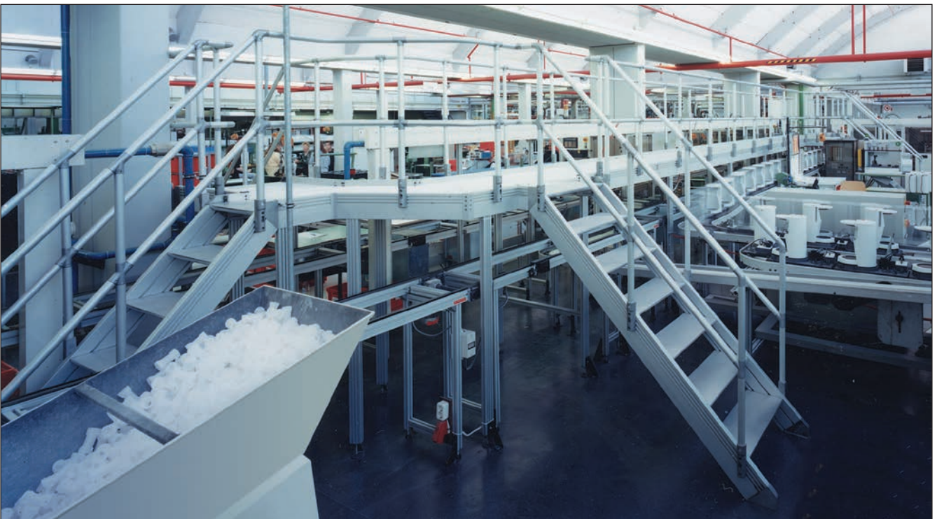
Treppenübergang aus ITAS-Elementen ermöglicht den Zugang verschiedener Fertigungsbereiche.
