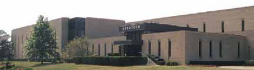
Unternehmenshauptsitz • Pittsburgh, PA • USA
